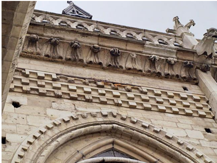
Haut-Chœur de Notre-Dame de Paris où l'on distingue, au centre, le chaînage de fer posé au XIX e siècle. Pour la future restauration des pierres abîmées par le feu et l'eau, des traitements de surface utilisant des bactéries seront testés. C. FRÉSILLON/AASPE/CNRS PHOTOTHÈQUE
