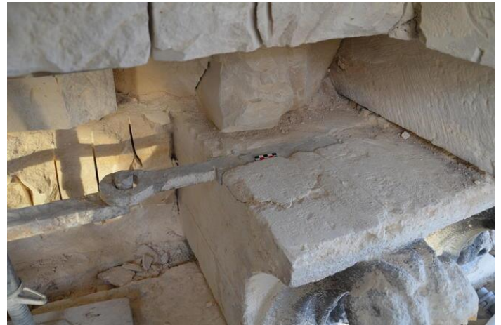
Chaînage de fer inséré dans la maçonnerie de la basilique Saint-Denis. Les analyses détermineront si Notre-Dame, elle aussi bâtie aux XII e et XIII e siècles, dispose du même type de consolidation.
